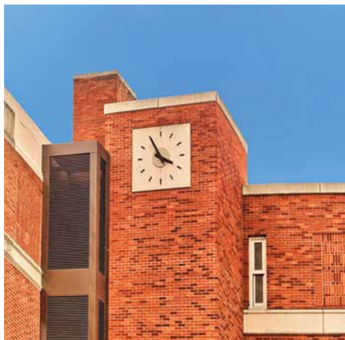
Über den Zielfonds Fengate Infrastructure Fund IV ermöglicht der BVT Concentio Energie & Infrastruktur II seinen Investoren Beteiligungen am Neubau des „Clackamas County Circuit Courthouse“ – in unmittelbarer Nähe der Großstadt Portland, Oregon. Die Verantwortlichen einigten sich auf eine Fertigstellung bis Mai 2025.
